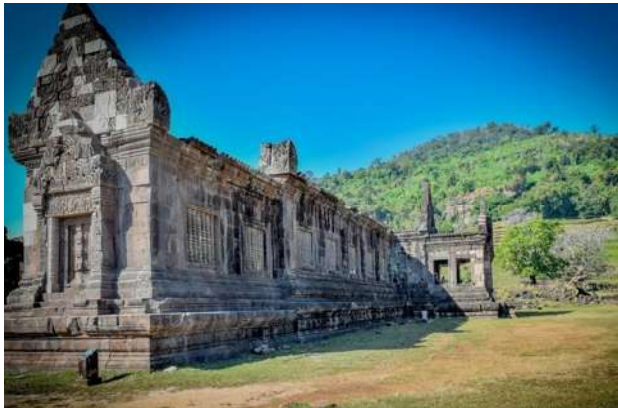
Fig. 37 : Vue des chantiers achevés de la restauration du porche nord (à droite) et du pignon est (à gauche) du palais sud de Vat Phu, financés dans le cadre des deux projets FSP.
